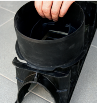
Einsetzen des Anschlussadapters für den Ablaufschacht
