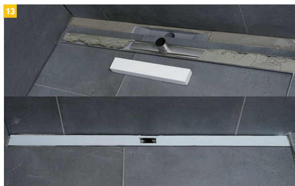
13 Nach der Belagsverlegung wird die Edelstahlabdeckung mit Fliesenkleber auf die erforderliche Höhe eingeklebt...
