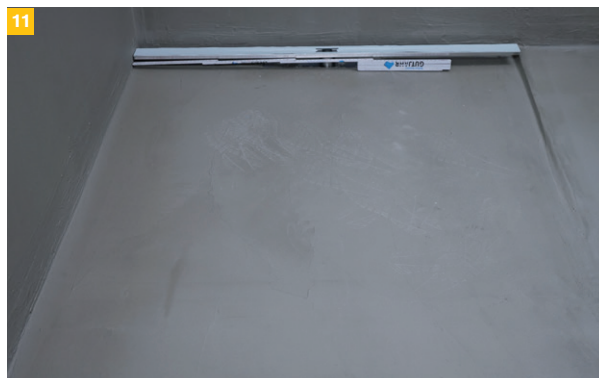
11 Die erforderliche Länge der Edelstahlabdeckung abmessen. Da der Ablauftopf nicht zwingend mittig eingebaut sein muss, ausgehend vom Ablauf die Länge links und rechts getrennt messen...
