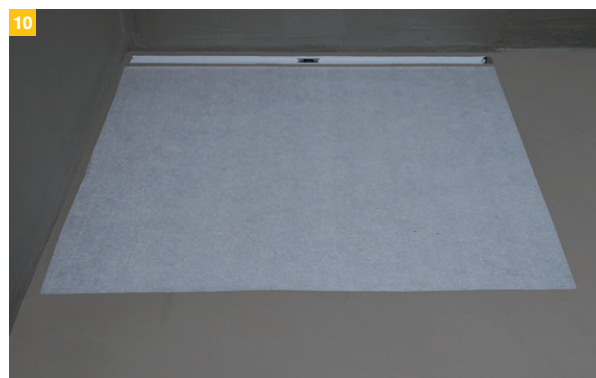
10 Wird eine Dämmung eingebracht, oder die Estrichüberdeckung kann nicht eingehalten werden, wird empfohlen die IndorTec® FLEXDRAIN-LP Lastverteilplatte einzusetzen. Dies gewährt eine sichere Lastverteilung des Oberbelags.
