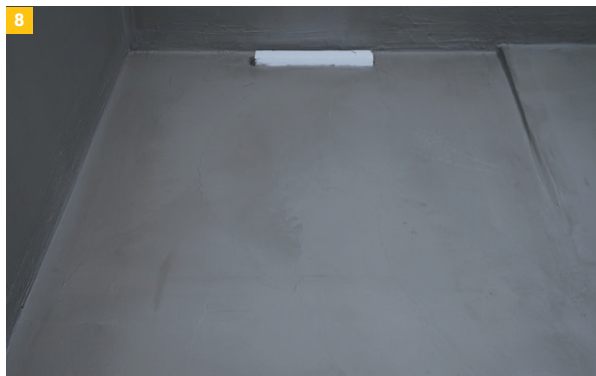
8 ...und nach Austrocknung des Estrichs die Duschfläche abdichten.
