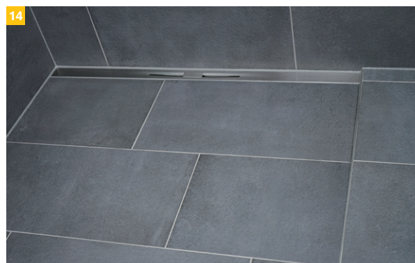
14 ...und die Anschlussfugen mit weichem Füllstoff verschlossen.
