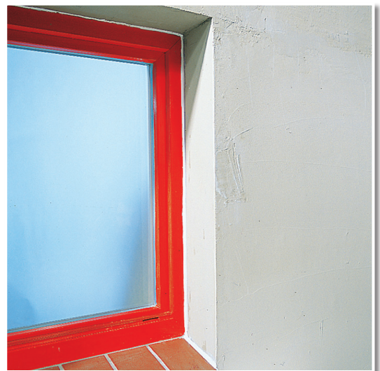
Verschluss der Anschlussfugen zwischen Fenster und Mauerwerk.
