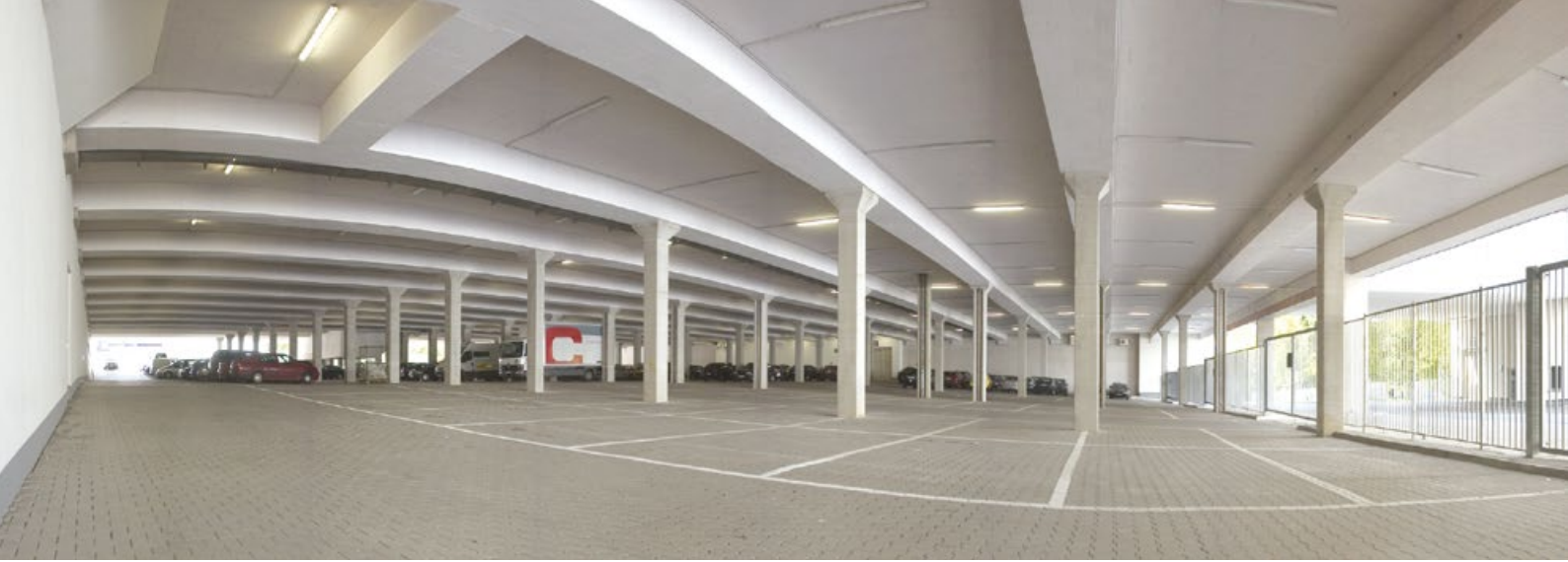
Großgarage unter der Westfalenhalle B3 in Dortmund
