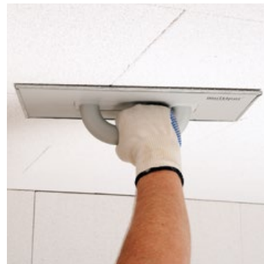
Einfaches Beischleifen
