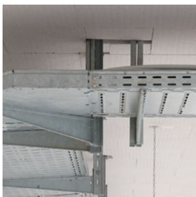
Befestigung eines Kabelträgers
