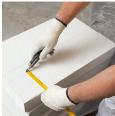
Platte ausklinken bei vorhandenen Leitungen
