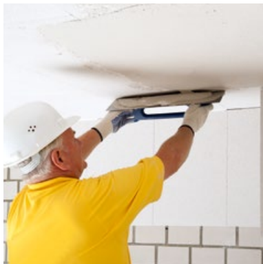
Multipor Leichtmörtel aufziehen
