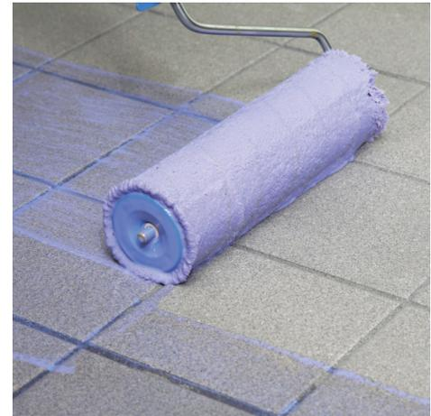
PCI Gisogrund 404 in der Kontrollfarbe violett ermöglicht eine hohe Verbundhaftfestigkeit von Ausgleichsmassen und Verlegewerkstoffen zum jeweiligen Untergrund.
