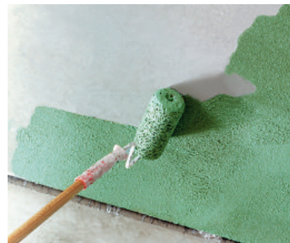
An der griffigen Gipsputz-Haftbrücke PCI Gisopakt kann sich später der Deckenputz fest verankern.
