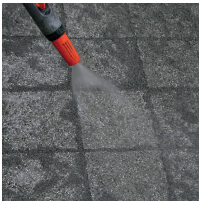
Bei Fugen von 3 - 8 mm das Einbringen in die Fugen mit dem Wasser- strahl unterstützen. Bei besonders schmalen Fugen den Wasserstrahl ent- lang den Fugen führen. Nachgesackte Fugen sofort mit frischem Material auffüllen.
