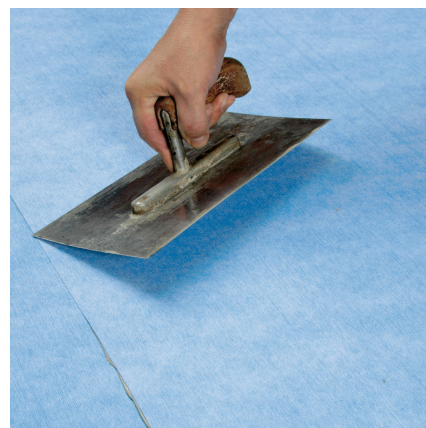
Bahnen mit Traufel, Gummiwalze oder Klopfbrett andrücken.
