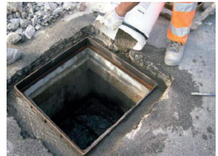
Ausgossen eines Kanalschachtrahmens mit PCI Repafast Fluid.
