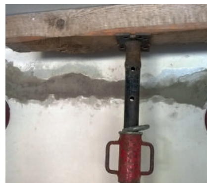
Unterstopfen eines Schlitzes in einer tragenden Wand mit PCI Repaflow USM.
