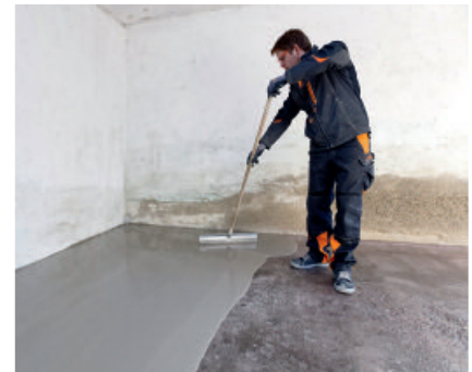
Vollflächiger Bodenausgleich mit leicht verlaufendem PCI Zemtec ® 1K für direkte Nutzbarkeit.
