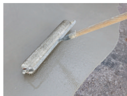
Auf der klebefreien, ausgehärteten Grundierung ausgegossenes und verteiltes PCI Zemtec 1K während des Einbaus mit einer Stachelwalze egalisieren und entlüften.
