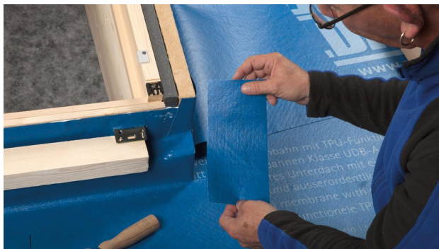
11. Ein Passtück zur Überdeckung der Einschnitte im Rahmen-Eckbereich zuschneiden. Ca. 15 bis 20 cm lang und ca. 10 bis 12 cm breit.
