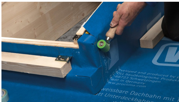
21. Verschweißung andrücken (z. B. mit Silikonrolle pro clima ROLLFIX).
