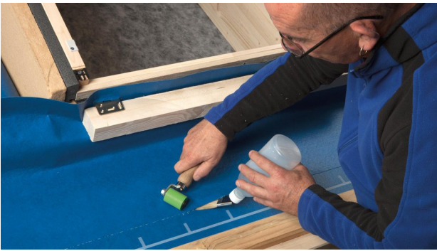
3. SOLITEX WELDANO-S 3000 an der Unterkante auf der flächigen SOLITEX WELDANO 3000 faltenfrei verschweißen (mit Quellschweißmittel oder Heißluftgerät).
