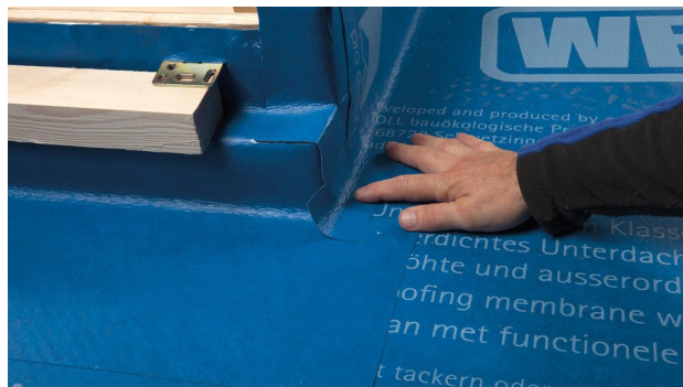
28. Auf wasserführende Bahnenüberlappung achten.
