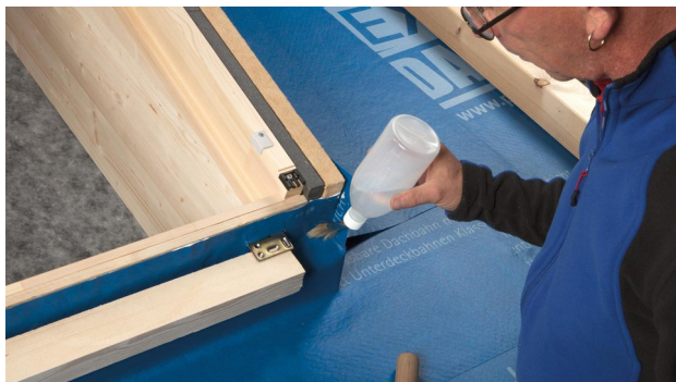
9. Zuvor gefaltete Ecke verschweißen.
