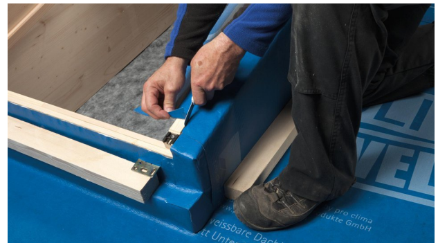
18. Parallel zum Fensterrahmen zuschneiden. Hierbei hilft eine Hilfsplatte zur faltenfreien Fixierung der unteren Kante.
