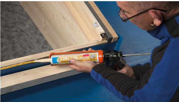
7. ORCON CLASSIC Raupe mit mind. 6 mm Durchmesser auf mineralischen Untergrund auftragen (bei rauen Untergründen ggf. mehr) und SOLITEX WELDANO-S 3000 an der Unterseite des Fensterrahmens ankleben.
