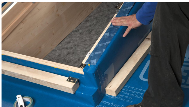
23. TESCON VANA zur praktischen Montage-Fixierung verwenden.
