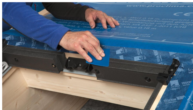
26. TESCON VANA zur praktischen Montage-Fixierung verwenden.
