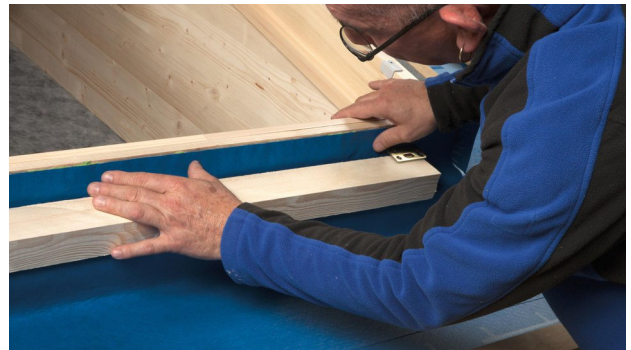
8. SOLITEX WELDANO-S 3000 mit Dehnschleife in das Kleberbett legen. Kleber dabei nicht ganz flach drücken, damit ggf. Bewegungen aufgenommen werden können.
