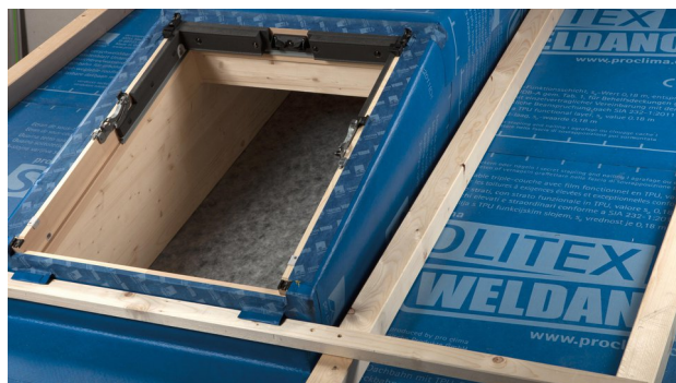
34. Konterratten und Tragplatten montieren und Montagewinkel verschrauben. Fertig.
