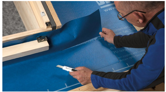
4. Horizontalschnitt bis Außenkante des Fensterrahmens/Dämmrahmens.
