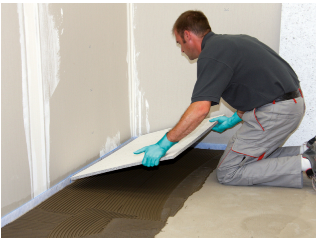
Eine Verlegung der Sopro FliesenDämmPlatte mit einem Sopro Flexkleber (z. B. Sopro´s No. 1) zum Auffangen von Bewegungen aus dem Untergrund ist im Anschluss dringend zu empfehlen.
