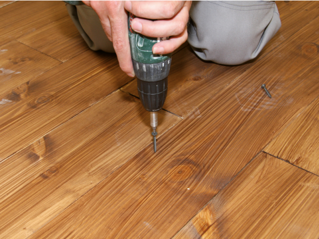
Nachverschrauben des sanierungsbedürftigen Holzuntergrundes zur Gewährleistung der Stabilität.
