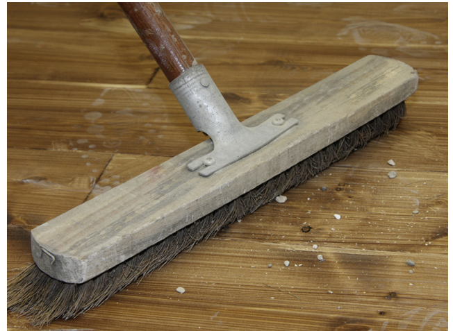
Die Fläche ist vor dem Auftrag des Sopro Haftvermittlers ausreichend von haftungsmindernden Stoffen (z. B. Staub) zu befreien.
