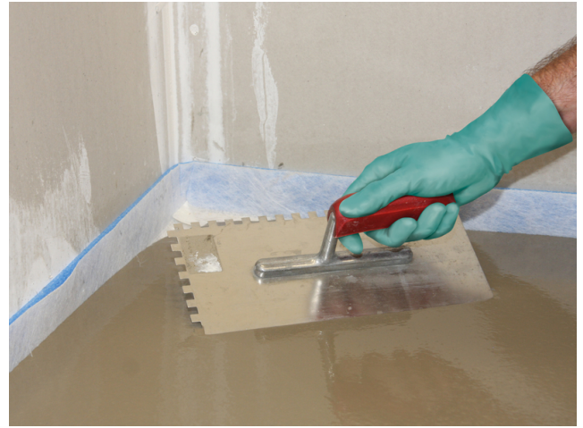
Mit einer Glättkelle oder einem Raket kann der Sopro FaserFließSpachtel gleichmäßig verteilt werden.
