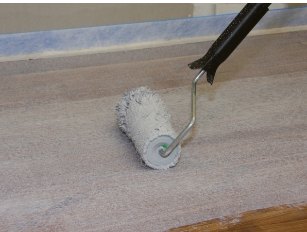
Der Holzuntergrund ist mit Sopro HaftPrimer S zu grundieren.
