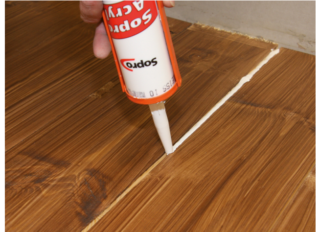
Fugen und Löcher sind mit Sopro Dichtacryl zu verschließen.
