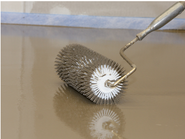
Zur Entlüftung eingeschlossener Luftblasen kann die Spachtelmasse mit einer Stachelwalze durchgerollt werden.
