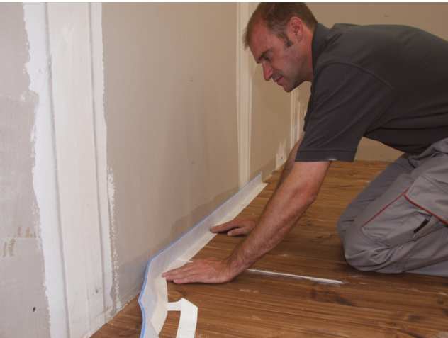
Um ein Hinterlaufen der Spachtelmasse zu verhindern, ist der selbstklebende Sopro RandDämmStreifen aufzustellen.
