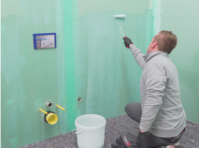
Saugende Untergründe mit Sopro Grundierung vorbehandeln.
