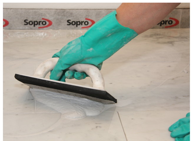
Einfugen von Sopro DF 10 in verarbeitungsempfindlichen Naturstein.
