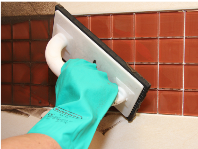
Einfugen von Sopro DF 10 in Glasmosaik.
