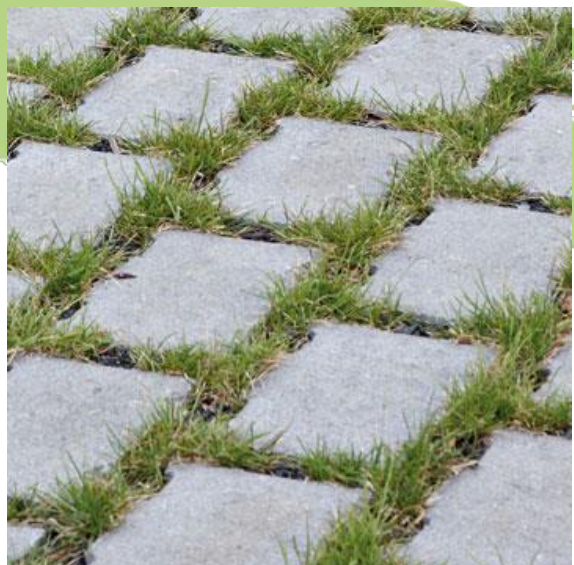
Abbildung 3: Beispiel Verlegte Fläche
