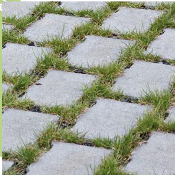
Abbildung 4: Beispiel Verlegte Fläche
