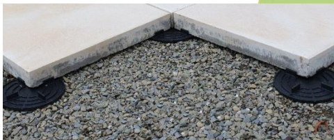
Abbildung 2: Beispielverlegung im Kiesbett. Verwendet wird: VP-U 4/10. Durch den 140mm Durchmesser wird das Gewicht der Platten großflächig verteilt.
